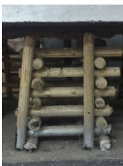
Hình 1.1. Vì chống cũi lợn bằng gỗ
