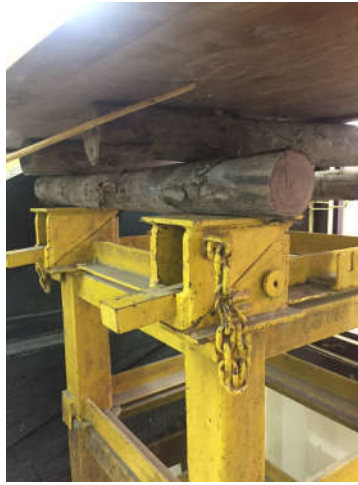
Hình 1.14. Dựng vì chống cũi lợn bằng sắt hoàn chỉnh
