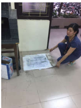
Hình 1.9. Dọn phẳng nền dựng vì chống
